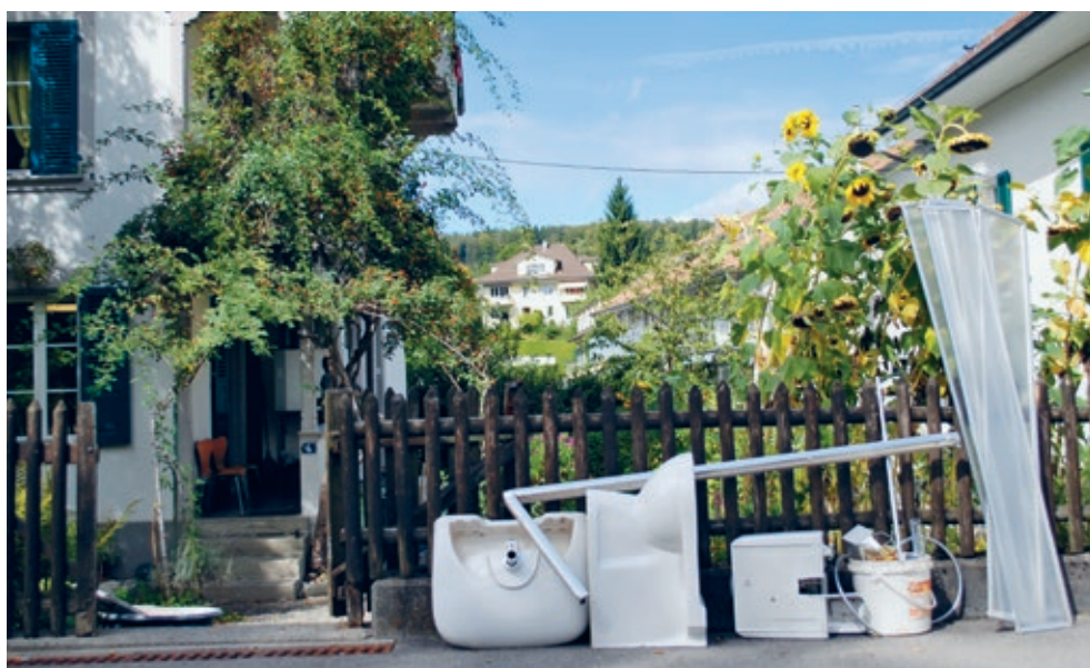
Ausgedient: Die alten Sanitäranlagen in der Wege Weierbühl werden ersetzt.
